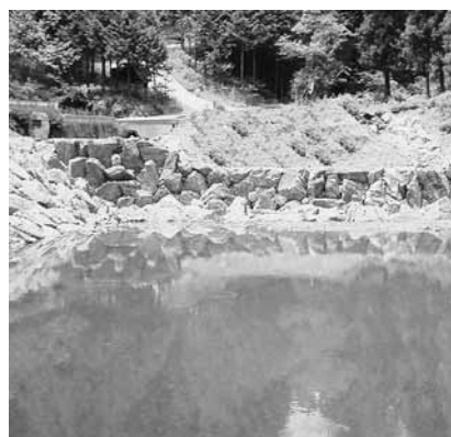
石丸積堰堤工
