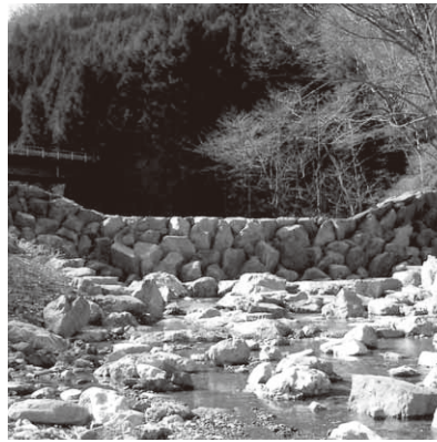
石丸積工法の施工実績
