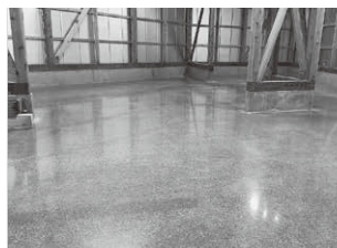
コンクリート鏡面加工 施工後の床
